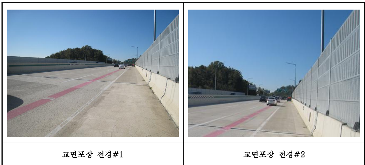
【사진 5.3.19】 교면포장 전경
