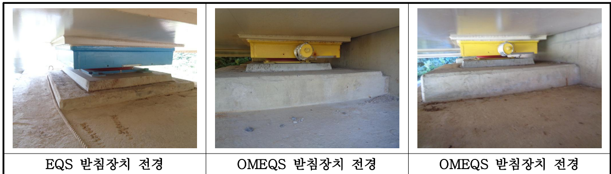
【사진 5.3.12】 교량받침 전경
