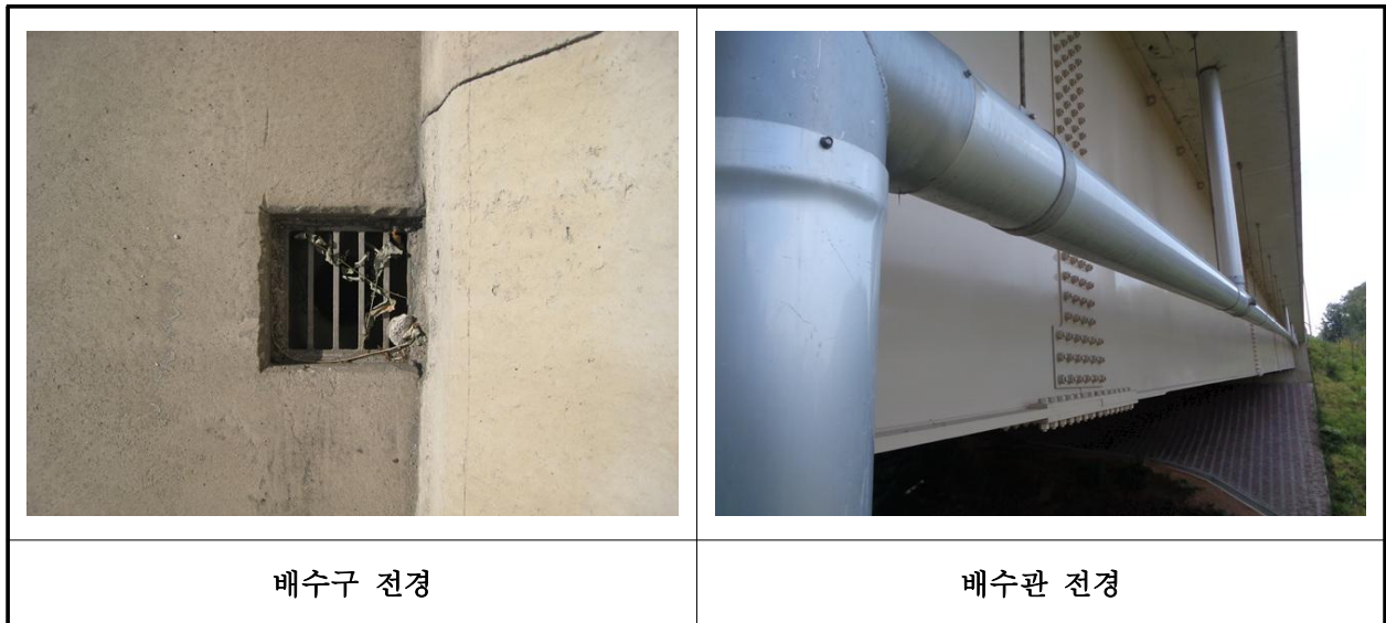
【사진 5.3.21】 배수시설 전경
