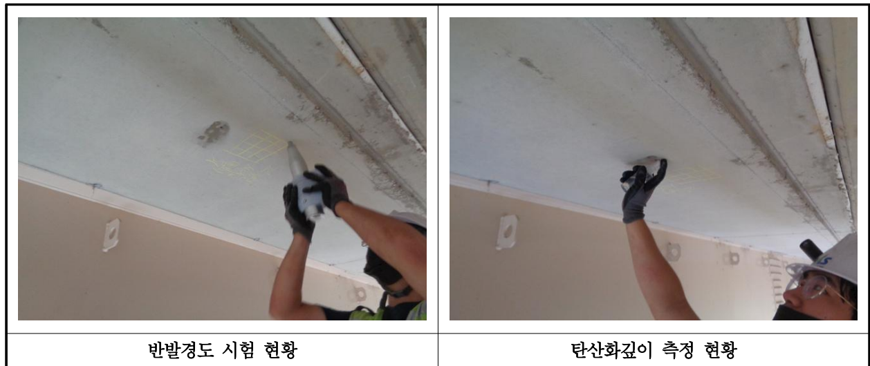
【사진 5.4.1】 콘크리트 내구성조사 현황
