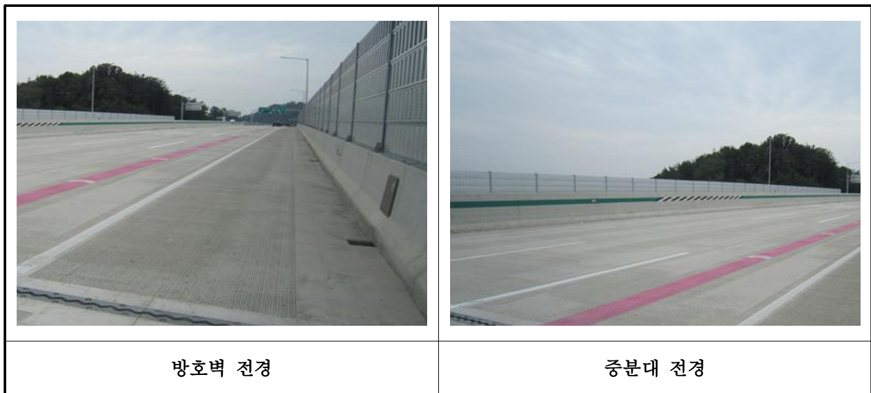
【사진 5.3.23】 방호벽 및 중앙분리대 전경
