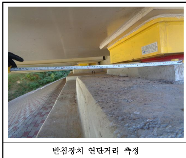
【사진 5.3.14】 교량받침장치 연단거리측정
