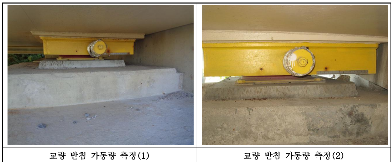
【사진 5.3.15】교량받침 이동량 측정
