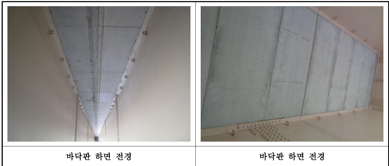
【사진 5.3.2】 바닥판하면 전경
